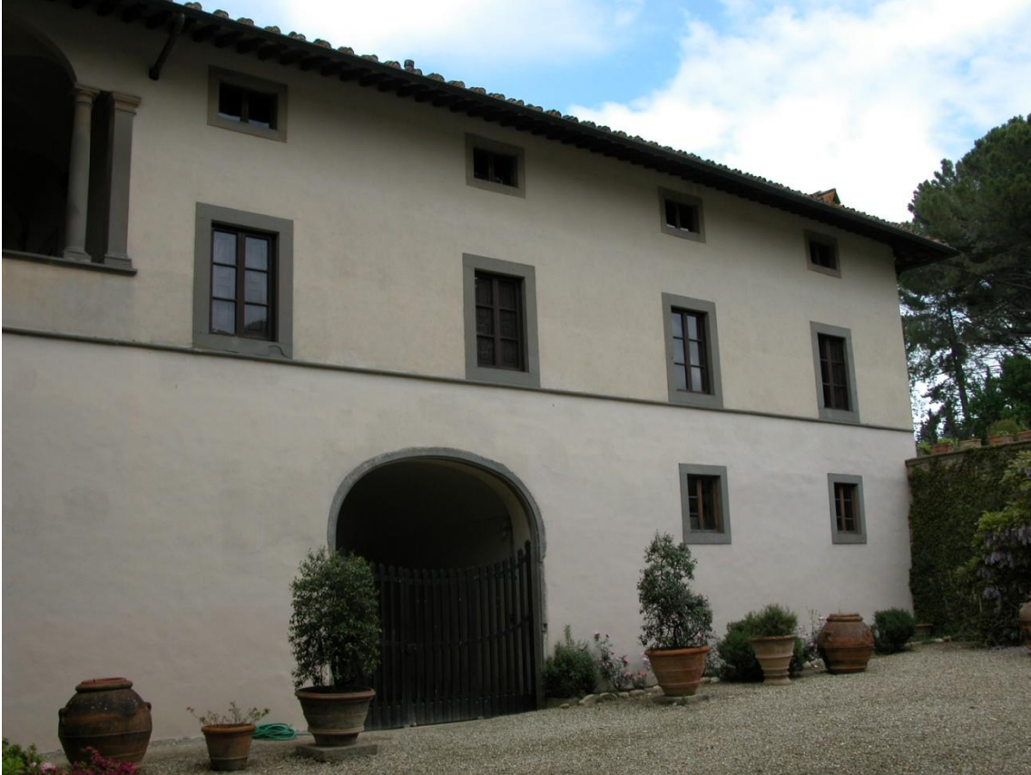
Foto dei prospetti: Prospetto frontale dal cortile interno
